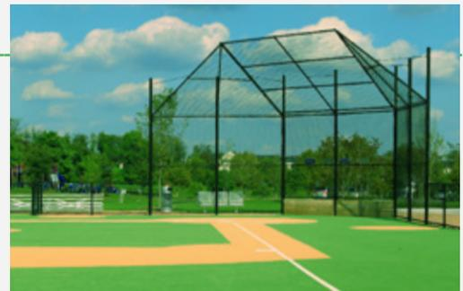
L'arrêt-balle avec toiture pourrait empêcher la tenue d'un championnat, car la distance entre le marbre et le fond de l'arrêt-balle n'est que très rarement réglementaire. Pour tenir un championnat, il faudra avancer le marbre de façon à respecter la distance minimale de dégagement arrière du marbre, mais alors l'arrêt-balle sera moins efficace. Les poteaux de délimitation du terrain devront également être déplacés.
