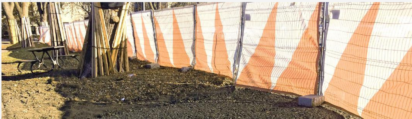
Protection du site
