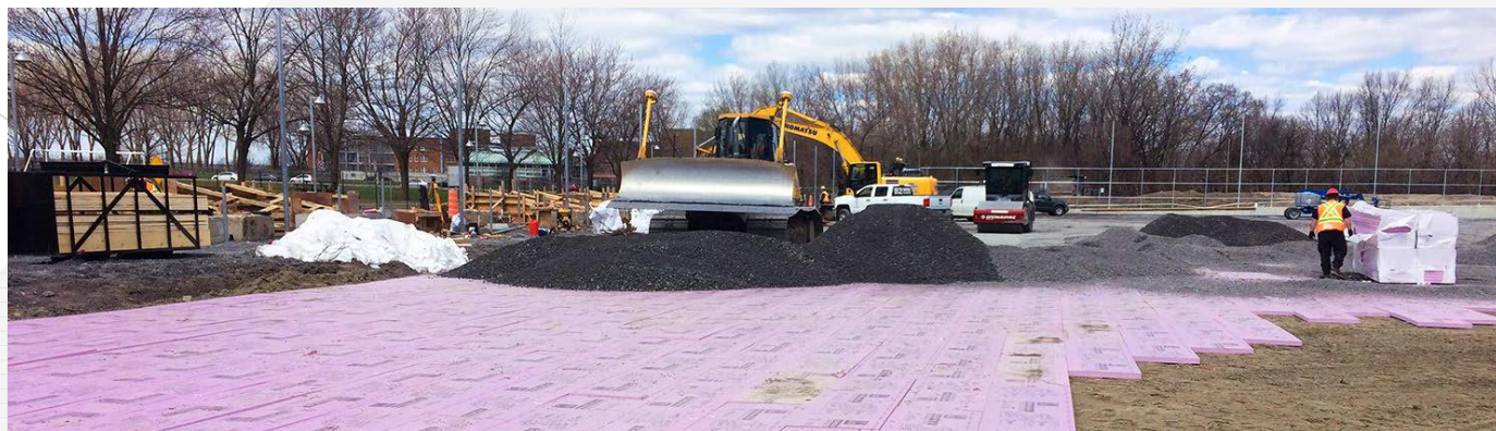
Fondation du terrain sportif — Granulats
