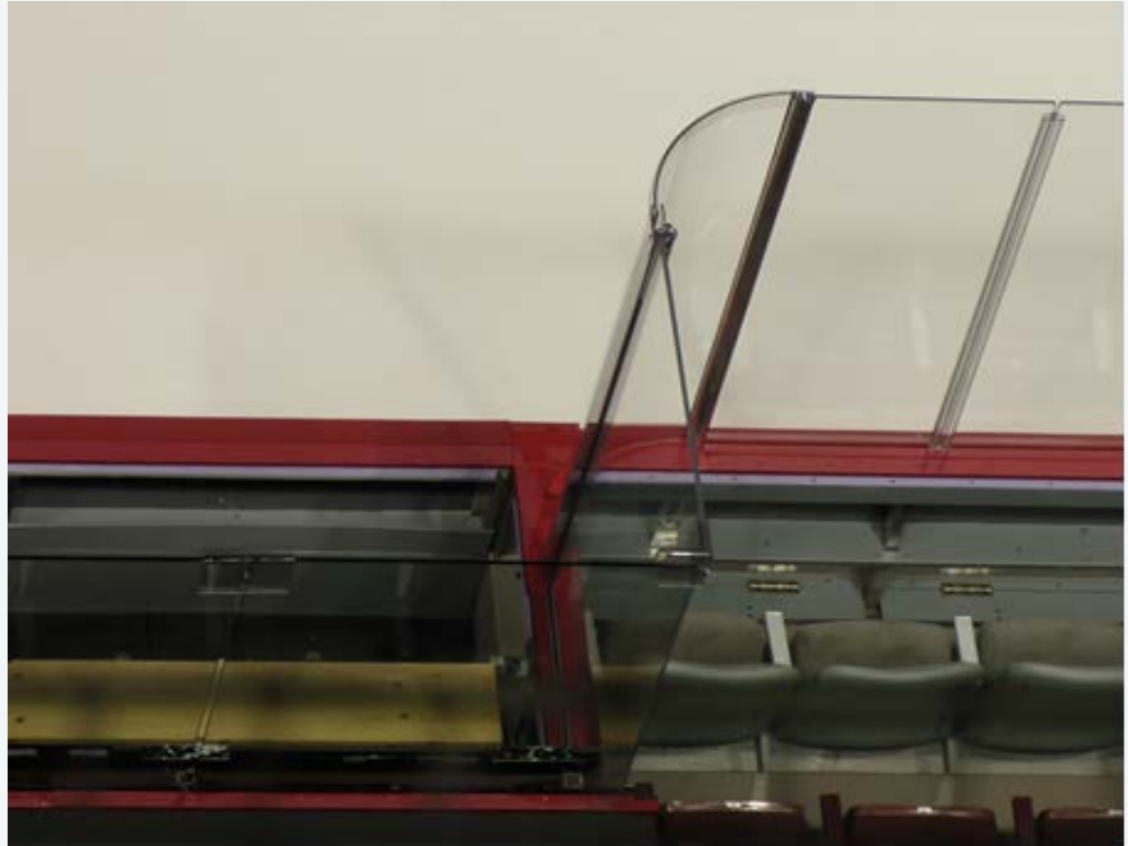
Figure 4 : Terminaison de fin de baie vitrée arrondie
